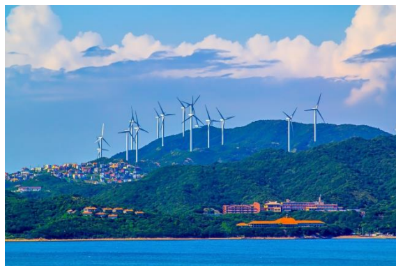
南あわじ市 風力発電所
