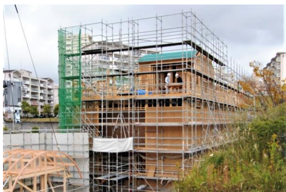
・名谷フォレスト保育園新築工事 株式会社村上工務店 提供
